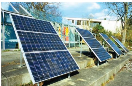
A **geração solar** ou **fotovoltaica** (geração de energia elétrica a partir da luz do sol) usa células solares feitas de um material chamado silício para produzir energia elétrica. Esse efeito é chamado de fotovoltaico porque na interação com as células solares de silício, a luz, ao ser absorvida, se converte em energia elétrica. Na foto vemos painéis compostos de várias células solares.
