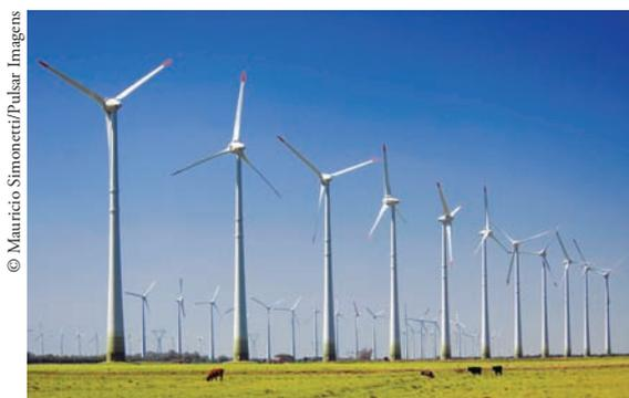
A **geração eólica** (geração de energia elétrica a partir do vento) ainda é um pouco cara, mas, nas regiões em que os ventos são intensos ou constantes, pode ser uma boa opção. As modernas turbinas de vento são formadas por um conjunto de pás ligadas a um eixo e a um gerador elétrico. Com elas, a energia dos ventos é convertida em energia elétrica.
