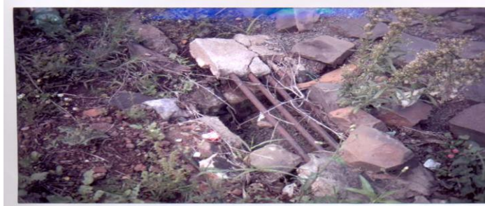
Foto 5: Boca-de-lobo - Rua Henrique Franzosi – depósito do lajeado Tigre Velho.
