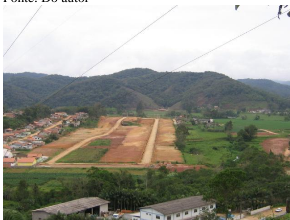
Foto 4: loteamento recém construido. Fonte: Do autor
